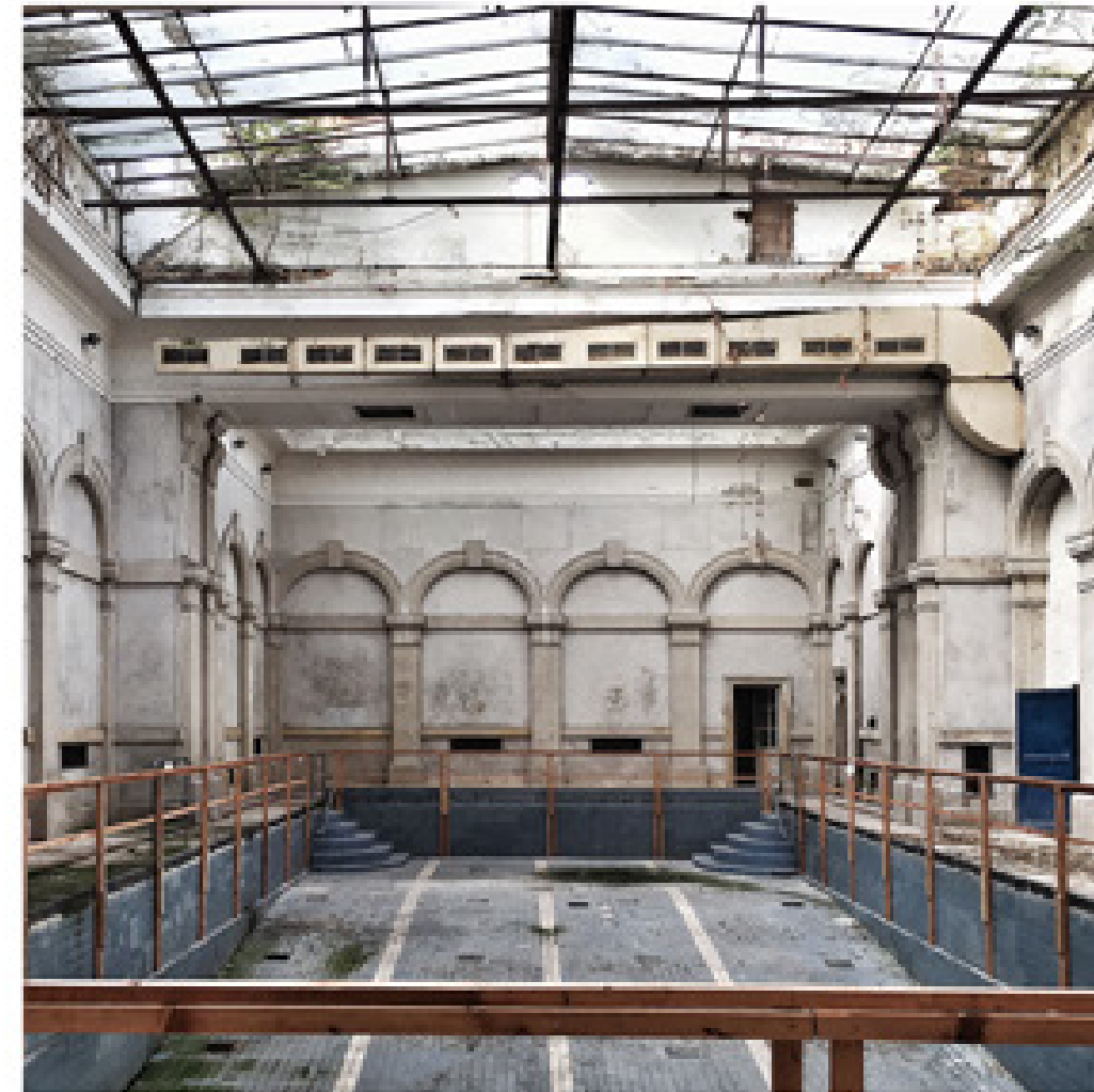
plavecký bazén - aktuální stav (2019)
