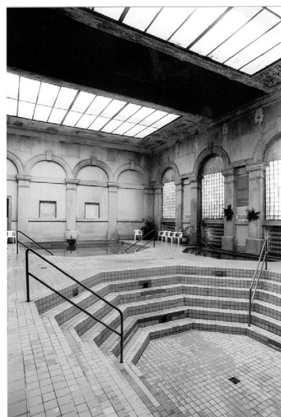
1898 - pohľad na sedací bazén
